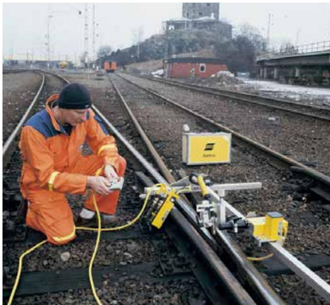
**Railtrac BV1000/BVR1000** (Рейлтрак БВ1000/БВР1000) — это автоматические установки для эффективного механизированного ремонта и твердосплавной наплавки ж/д рельсов. Один оператор может легко и быстро собрать, запрограммировать и управлять работой оборудования. Обучить оператора пользоваться установкой исключительно просто и быстро.
